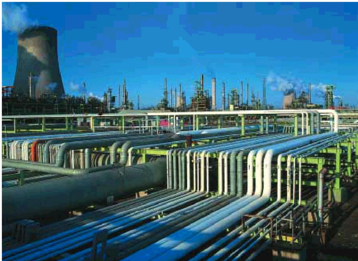
▲位于南非 Secunda 的 Sasol 合成燃料厂。Sasol 拥有两家类似工厂，应用天然气合成油（GTL）技术将煤制气转化成液态燃料。（Sasol 有限公司图片版权所有。）
