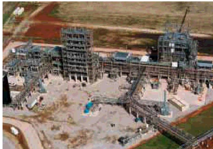
▲位于美国俄克拉何马 Ponca City 的大陆菲利浦斯石油公司 GTL 示范厂。该厂于 2003 年 3 月竣工, 设计日处理天然气能力 400 万立方英尺 (114600 立方米), 日产无硫柴油和石脑油 400 桶 (64 立方米)。(大陆菲利浦斯石油公司图片版权所有。)
